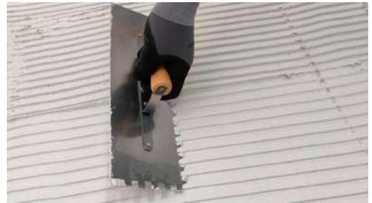
\* No extienda el pegamento en áreas de más de 1 m<sup>2</sup> a la vez, para no exceder el tiempo abierto indicado por el fabricante (para que no pierda adhesividad)
