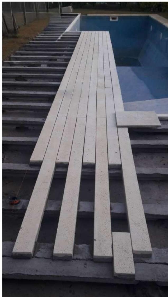
\* La diferencia de espesor entre las piezas se regula con el pegamento.
